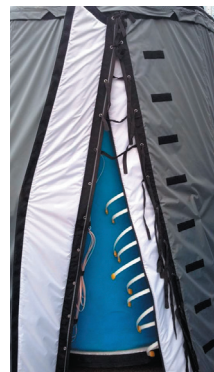
Рисунок 1. Временная фиксация чехла на емкости
